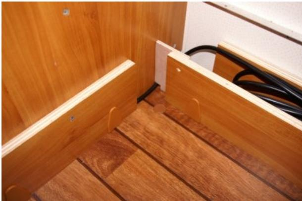
Le devant doit être modifié pour le passage du câble en dégageant l'angle !!!!
