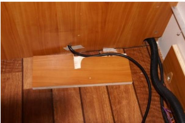
Avant fixation, un petit essai pour que le câble ne soit ni plié ni pincé !!!!
